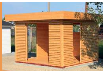
Coffrage de toit et de mur
