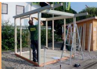
Montage de l'ossature autoporteuse
