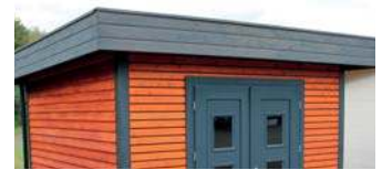
Toit plat (avec avancée de toit)
